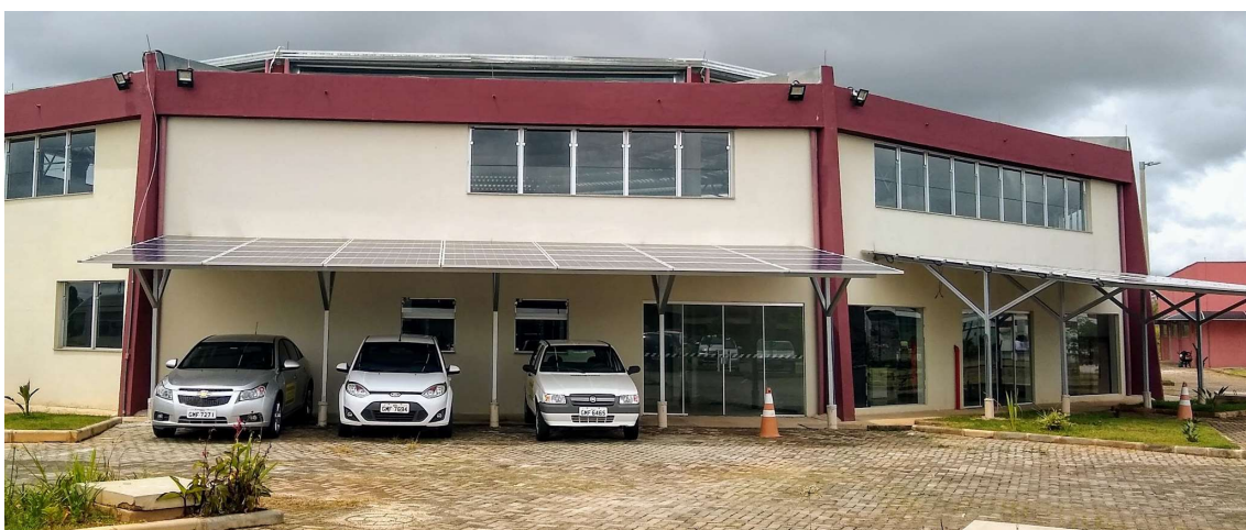
Fig. 9 - Carport Sistema Fotovoltaico instalado na biblioteca do Campus Poços de Caldas.
