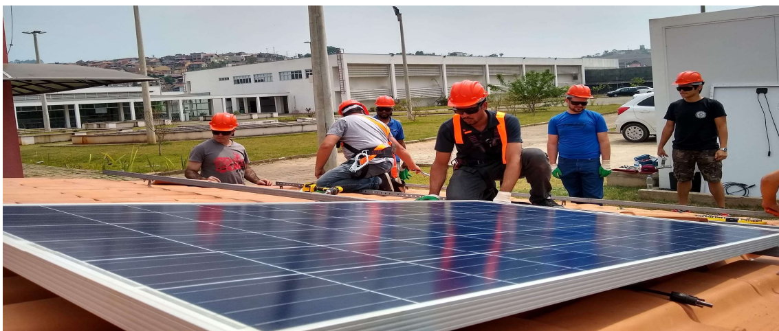
Fig. 7 - Aula no telhado didático
