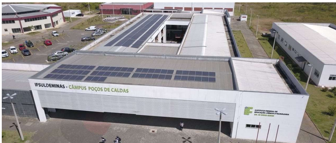
Fig. 11 - Usina de 70 kWp
